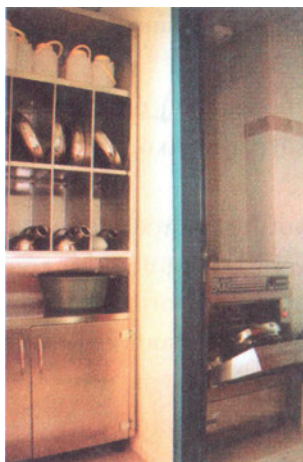
Εικ. 40 Πλυντήριο σκωραμίδων και ουροδοχείων.
